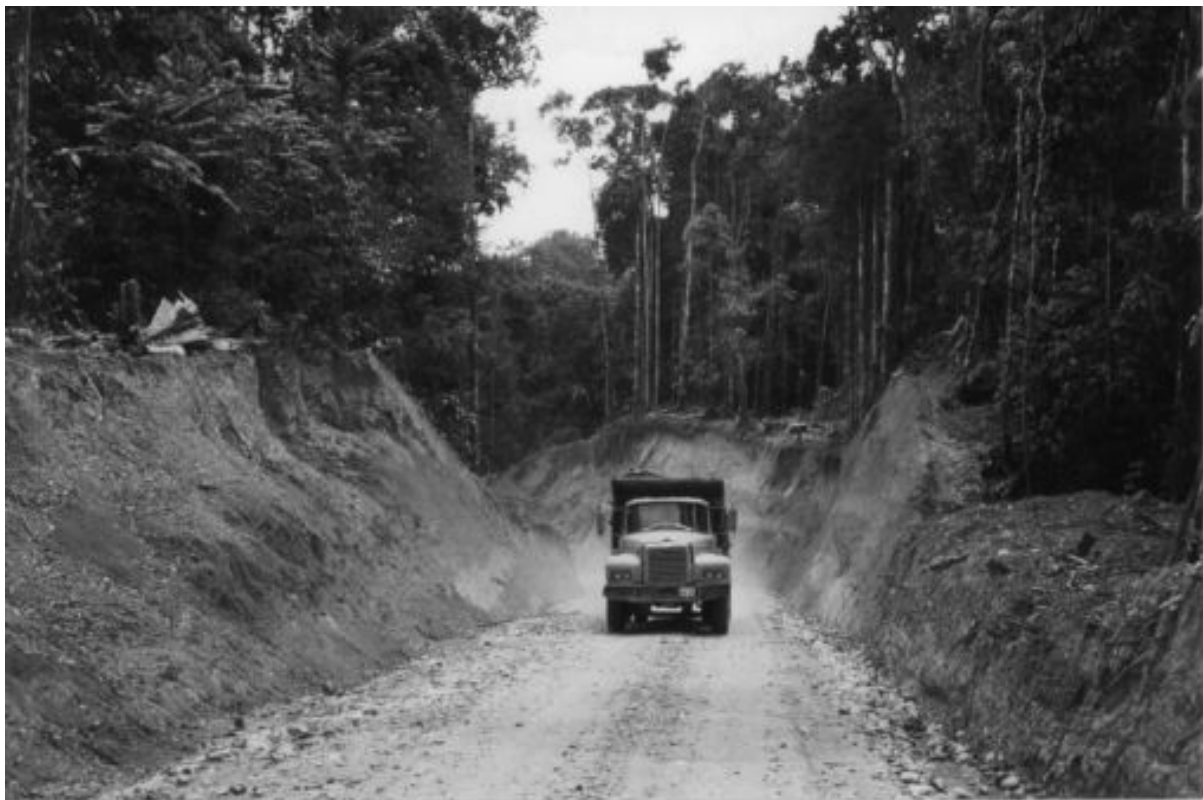
Foto: Straßenbau im Amazonasgebiet von Ecuador (S. REINHARDT)
